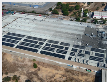
Instalação parque fotovoltaico
